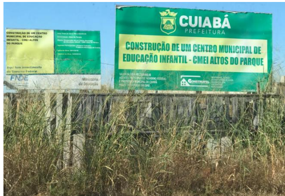
Figura 5 - CMEI Altos do Parque com construção em atraso.
