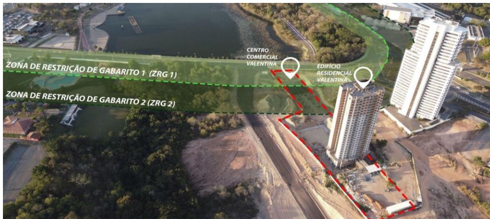
Figura 4 - Relação entre Parque das Águas, Zoneamento e Ed. Res. Valentina, em construção.
