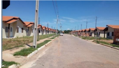
Figura 4 - Fotografia de uma das ruas do Residencial Dom Máximo em Cáceres-MT
